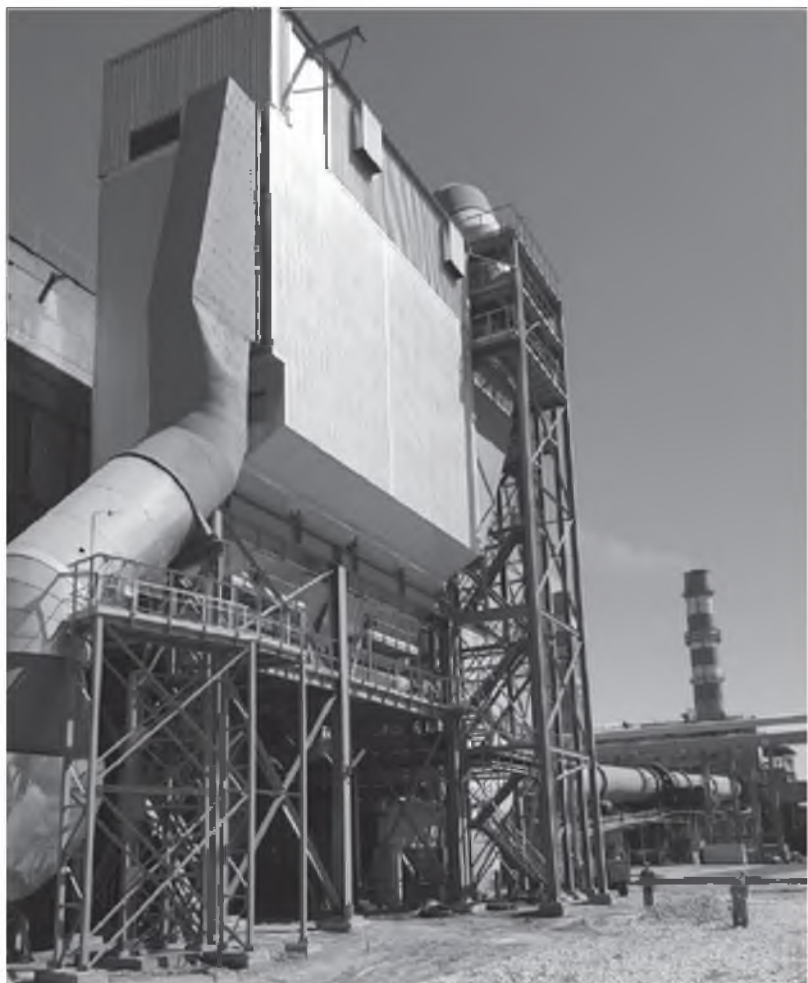
АО «ХК «Сибцем» продолжает модернизацию оборудования (на фото – техпервооружение аспирации колосникового холодильника печи № 9 АО «Искитимцемент»)
