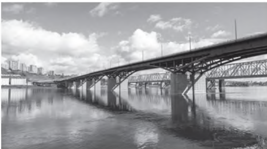
4-й мост через Енисей в г. Красноярске
