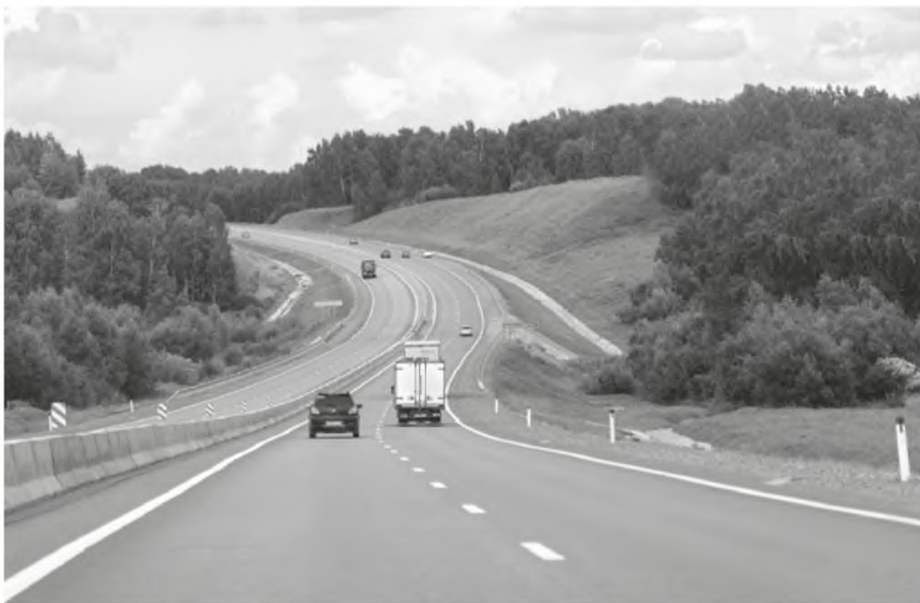
«Сибцем» движется вперед, выпуская продукцию для строительства дорог, мостов и зданий (на фото – Северный объезд Новосибирска)
