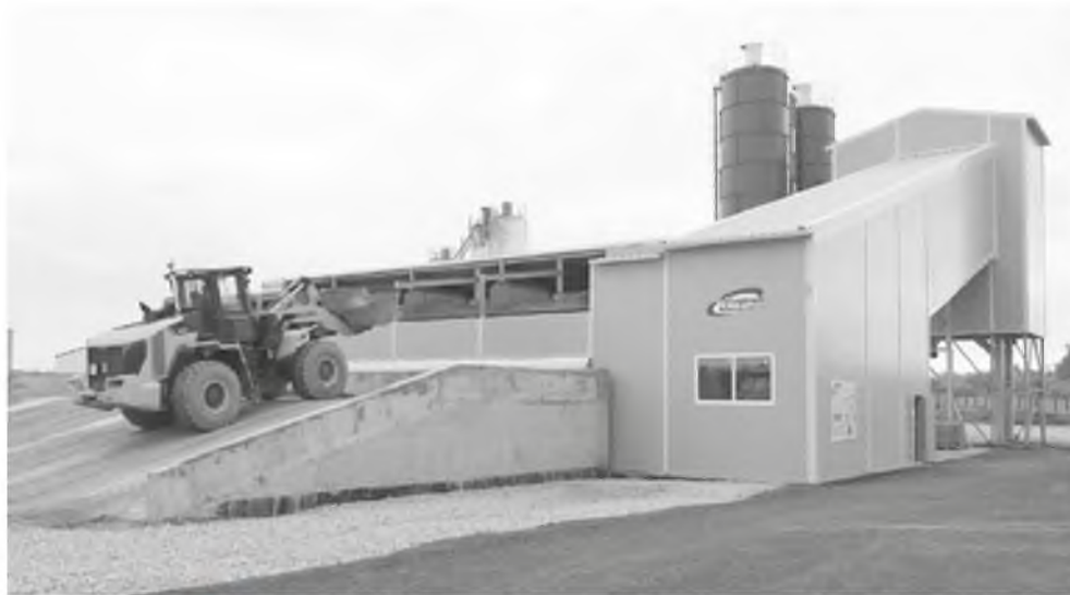
Идет подготовка к процессу дозирования сырья и изготовлению смеси
