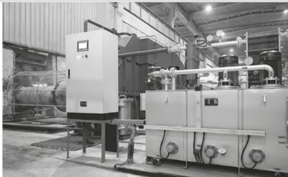
Новый редуктор в сырьевом цехе ООО «Топкинский цемент»
