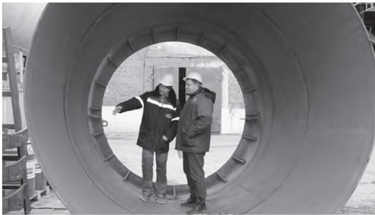
Идет осмотр конусной обечайки
