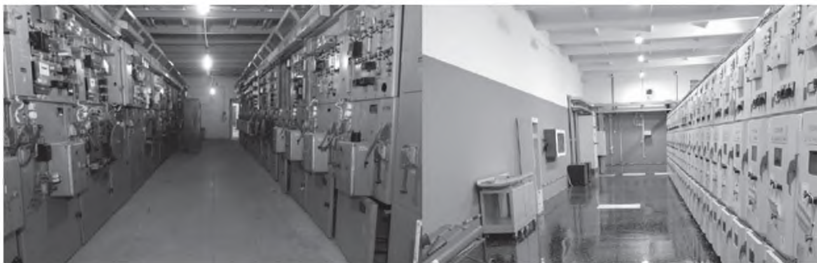
Трансформаторную подстанцию № 5 обновили до версии 2023.0
