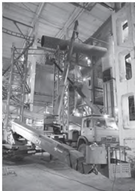
Идет монтаж опор газохода
