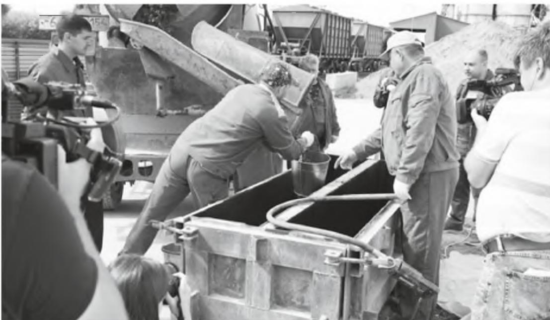
Отбор проб для передачи в независимый испытательный центр проводился на площадке «Сибирского бетона»
