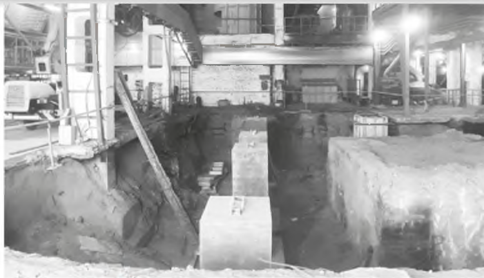
Ведется устройство фундаментов опорных конструкций рукавного фильтра
