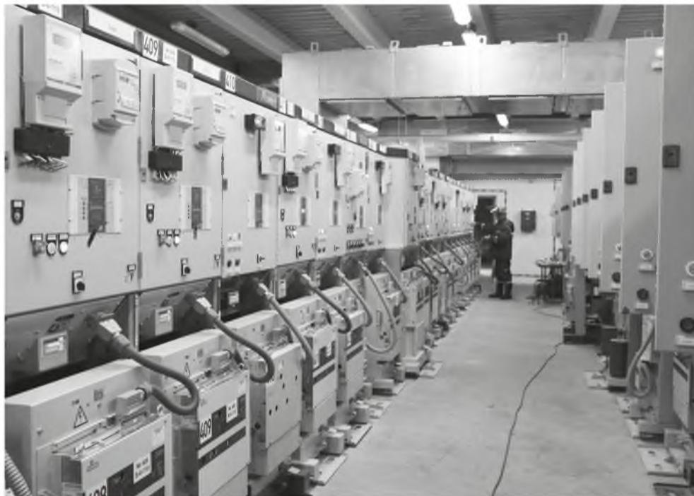
Многие работы проводятся без остановки основного технологического оборудования
